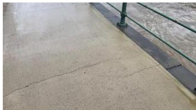
© S.B. Déjà des fissures sur les quais le long de la Meuse.
