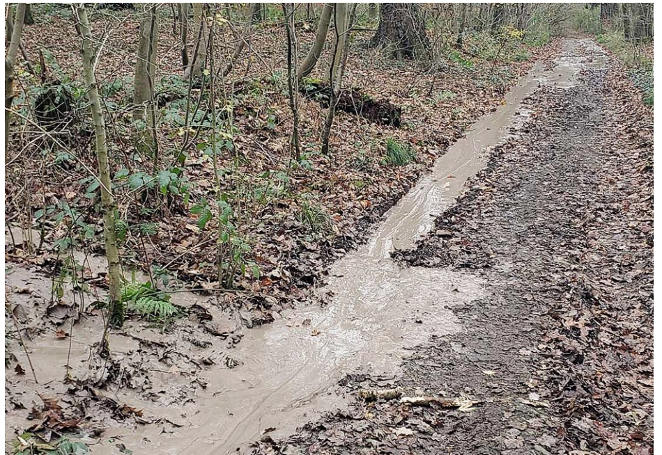
■ Une fuite de bentonite sur le chantier Elia à Seraing. © DR
